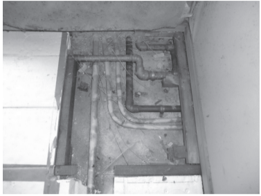
専有部分給排水管更新工事
