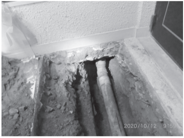
排水管L字交換と地盤確認
