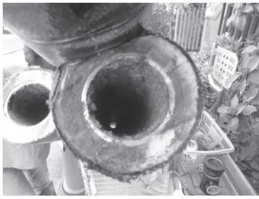
旧排水管断面
